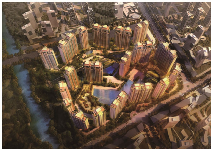
仁恒滨河湾二期住宅工程
